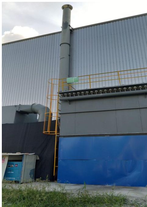
旋风除尘+布袋脉冲除尘装置
